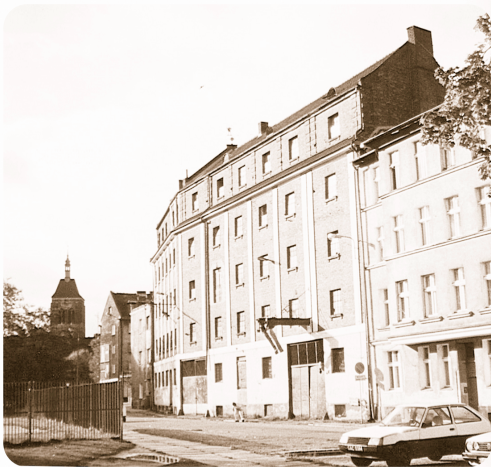
Młyn na Tartacznej przed przebudową.
