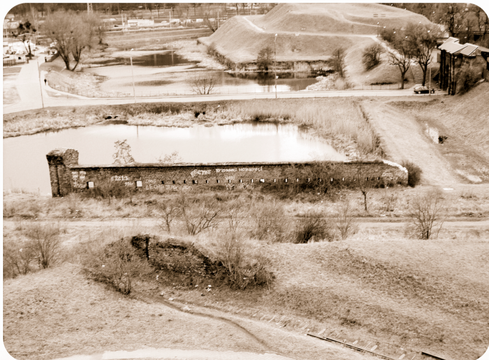
Pozostałość po bramie kolejowej między Bramą Niziną a Bastionem Żubr.
