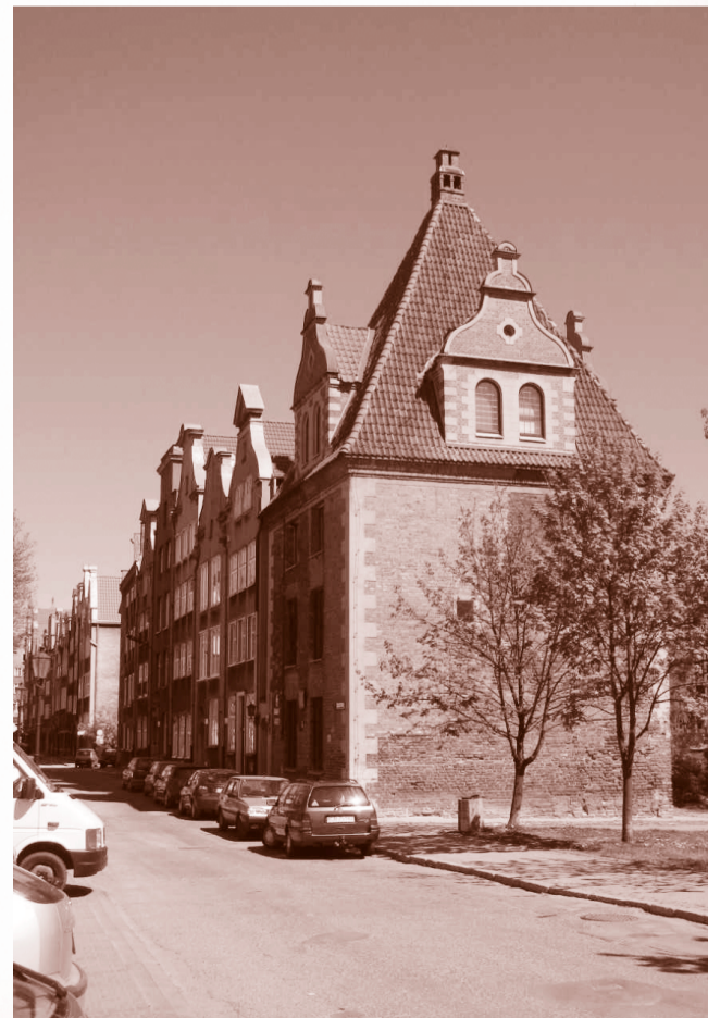
Ulica i baszta Kotwiczników
