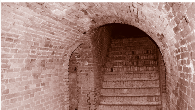
Podziemna część mostu od strony wschodniej
