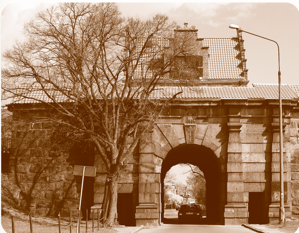
Brama Nizinna, którą niebawem czeka gruntowna rewitalizacja
